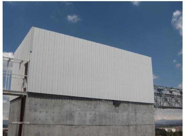
Para la fijación de estas tejas se utilizan tornillos auto perforantes en cada correa y con una distribución similar a la utilizada en una cubierta. Por motivos estéticos, no se suele utilizar tornillos fijadores de ala.
